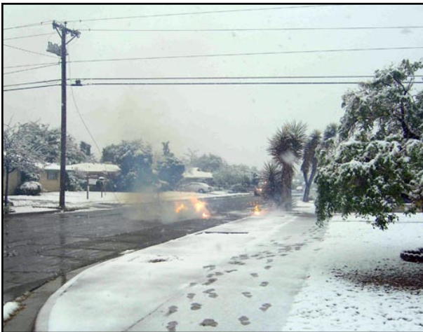
Las líneas de electricidad que están caídas crean condiciones peligrosas.
