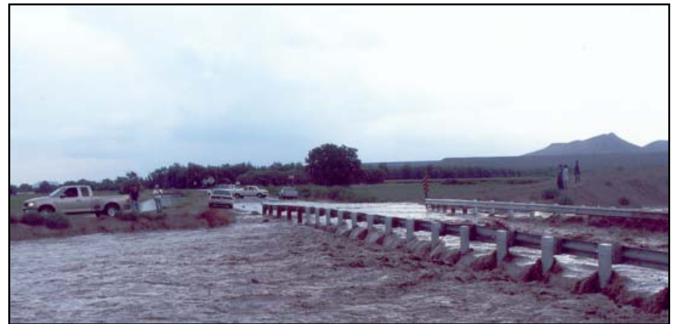
El Arroyo de Placitas sobre pasa Channel Road, Hatch, NM, 2002; Foto tomada por un residente de Hatch
